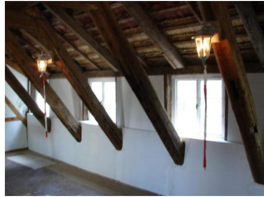
...und durch MDF-Platten ersetzt und mit Dispersionsfarbe überstrichen.
